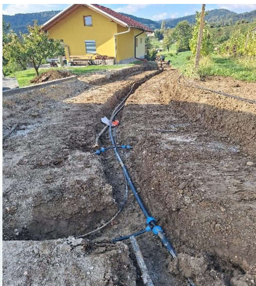
Slika 3: Obnova vodovoda Orešje na Bizeljskem
